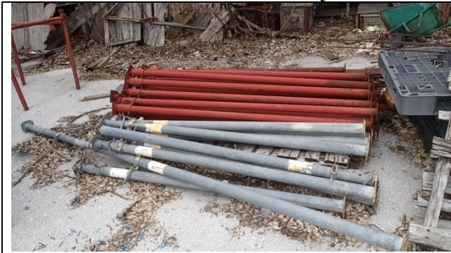
38. Elementi montažne skele Doka – elementi su razbacani desortirani, cijevi su korodirane , ima dosta savijenih i oštećenih.
