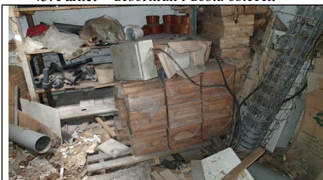
45. Parket – desortiran i dosta oštećen
